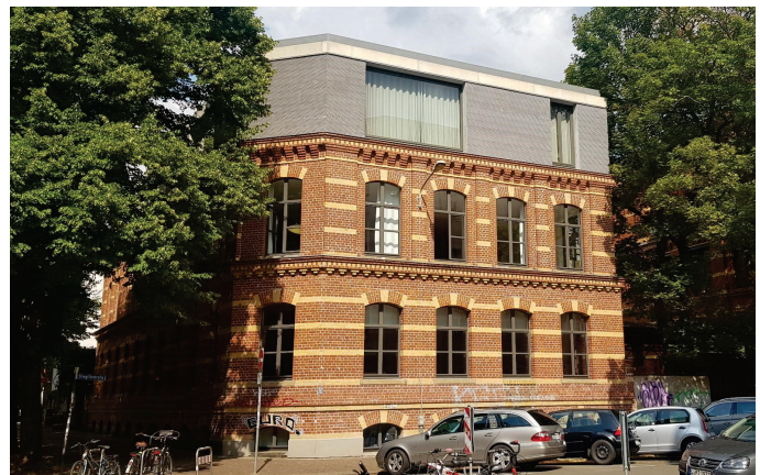
Abbildung 12 Kontorhaus in Leipzig - Geschossaufstockung Holz-Leichtbau (Foto von Nora Mittelstädt 2022)
